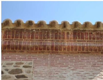
CONVENTO CARMELITAS DESCALZAS. CORNISA
