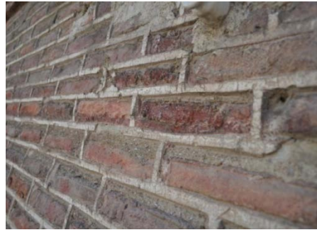
DETALLE DE PARAMENTO
