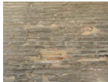
Reparación/imitación llaga resaltada
