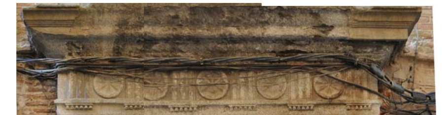
Daños en la portada localizados en su parte superior por la escorrentía incontrolada procedente del balcón superior. Puede apreciarse en la parte central de la cornisa, la fuerte erosión producida
