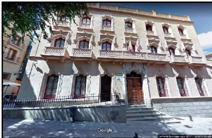
El antiguo Hotel Castilla, sede de la Tesorería de la Seguridad Social, fue construido a finales del XIX sobre el solar del convento de San Agustín.
