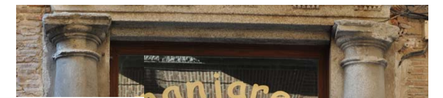
Daños en la portada localizados en su parte superior por la escorrentía incontrolada procedente del balcón superior. Puede apreciarse en la parte central de la cornisa, la fuerte erosión producida
