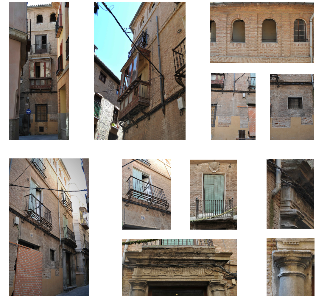
Fachada de orientación norte, cuerpo principal de cuatro plantas, ocupado por una crujía de 4m de ancho que se manifiesta formalmente al exterior en un cuerpo de edificio con identidad propia, rematado con una galería y de aspecto palaciego
