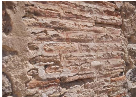
DETALLE DE PARAMENTO
