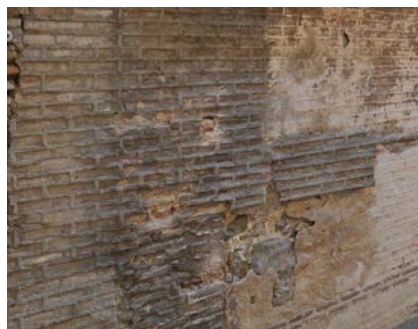
REPARACIONES Y PARCHEOS
